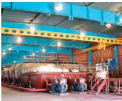
Отремонтированный цех на глинозаводе.
