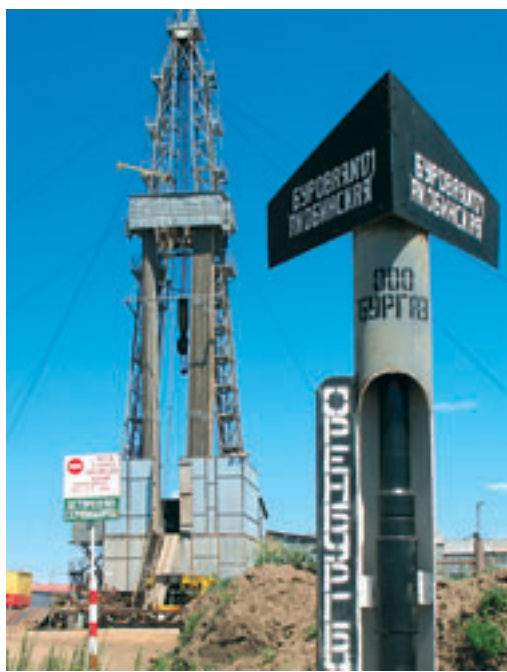
Первая скважина № 171 на Ақобинском ГКМ.
