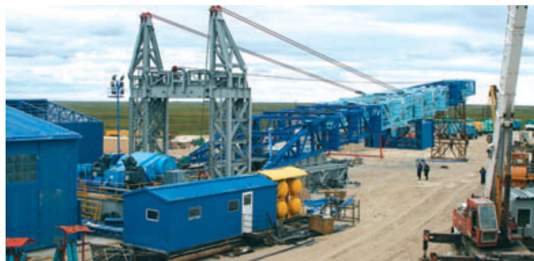
Идет монтаж новой румынской буровой установки F-320.
