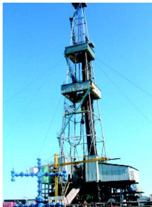
Буровая на Песчаной площадке.
