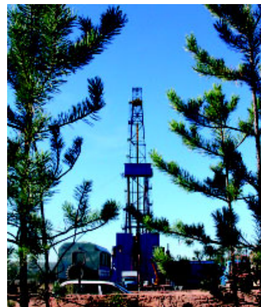
Завершается бурение скважины № 1 Чунской.
