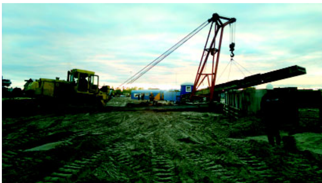
Монтаж БУ-3000/200ЭУК/НЕБ3200 на объекте ОАО «Газпромнефть-ННГ».
