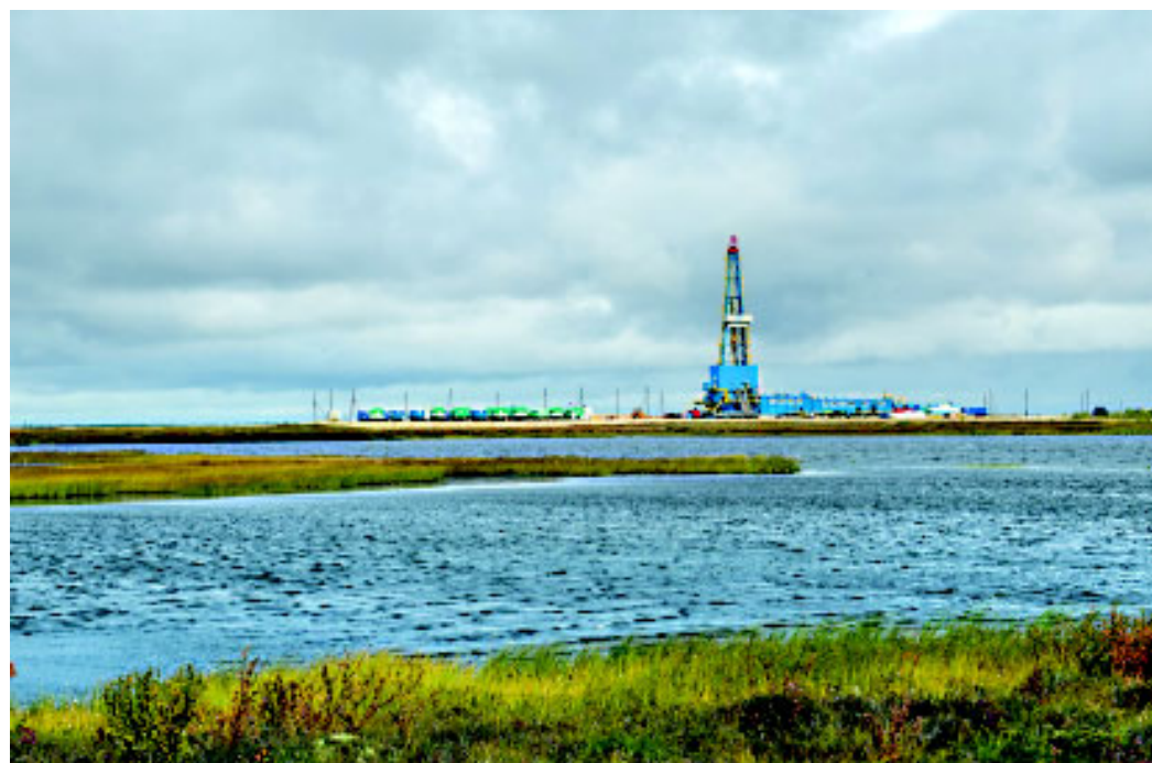
На 2-м ачимовском участке Уренгойского НГКМ работает новая БУ-5000/320ЭК-БМ(Ч).
