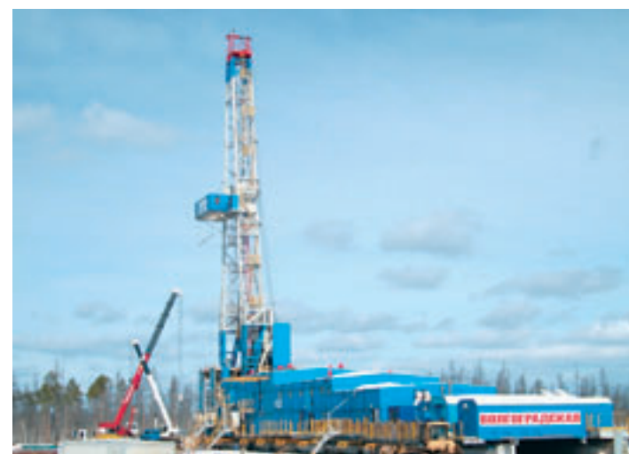
Монтаж буровой Волгоградского ЗБТ на Дулисьме.
