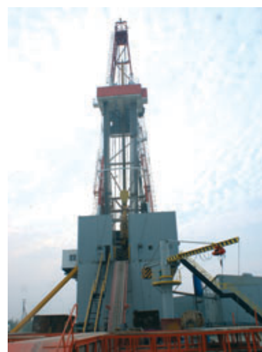
Немецкая буровая установка «Bentec» бурит скважины для ЗАО «Роспан».
