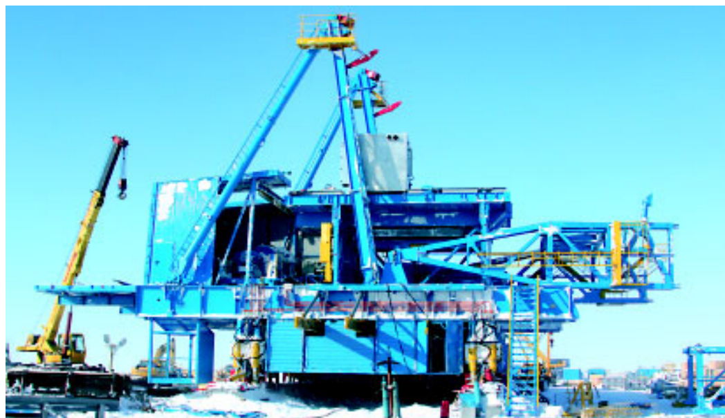
Монтаж БУ5000/320ЭК-БМ(Ч) на кусту № 5 месторождения им. Р. Требса (фото А. Коновалова).
