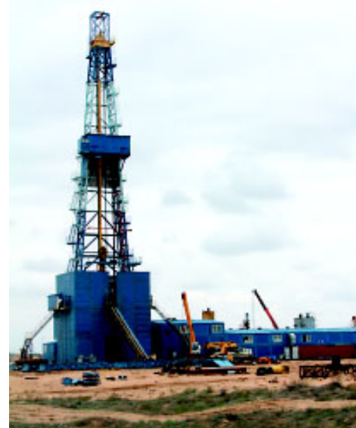
Буровая № 939 на Астраханском ГКМ.
